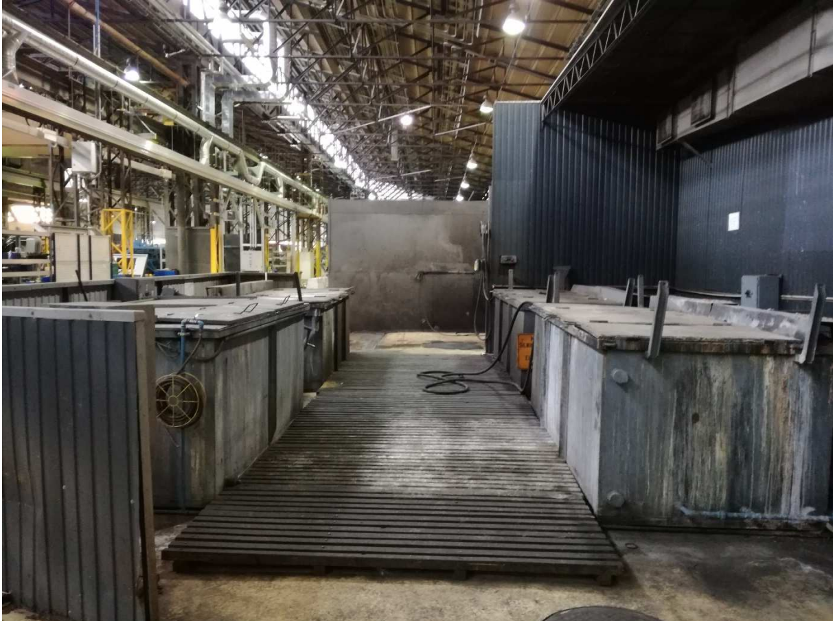
Rysunek 2. Widok na stanowisko do zanurzeniowego płukania metali (widok na wanny do odtłuszczenia stali)
