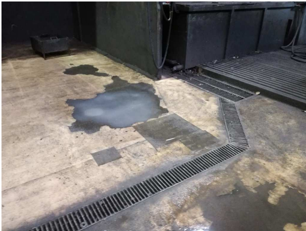
Rysunek 6. Kanały odprowadzające ścieki ze stanowiska.
