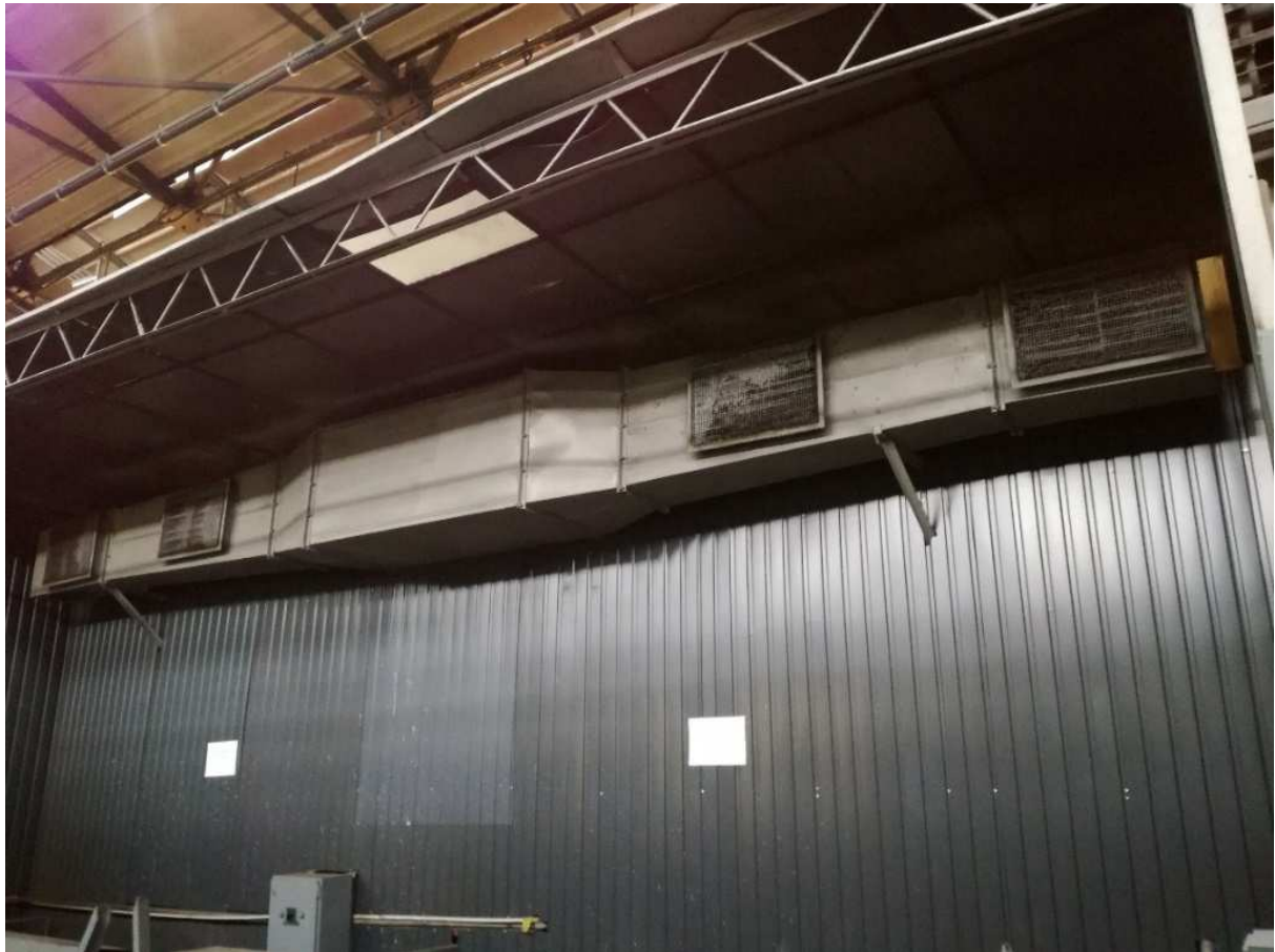
Rysunek 6. Wloty ssaw wentylacji ogólnej mechanicznej stanowiska.
